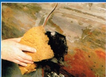
Mit Wasser und einem Schwamm werden nun die Fertan-Reste einfach abgewaschen
